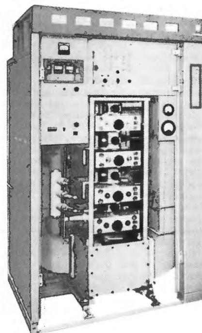
Fig. 3 - Montaggio di un klystron YK1001 nello stadio finale di un trasmettore video da 10 kW.
